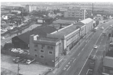
新工場棟が完成。手前が川口工場、奥が従業員寮。
